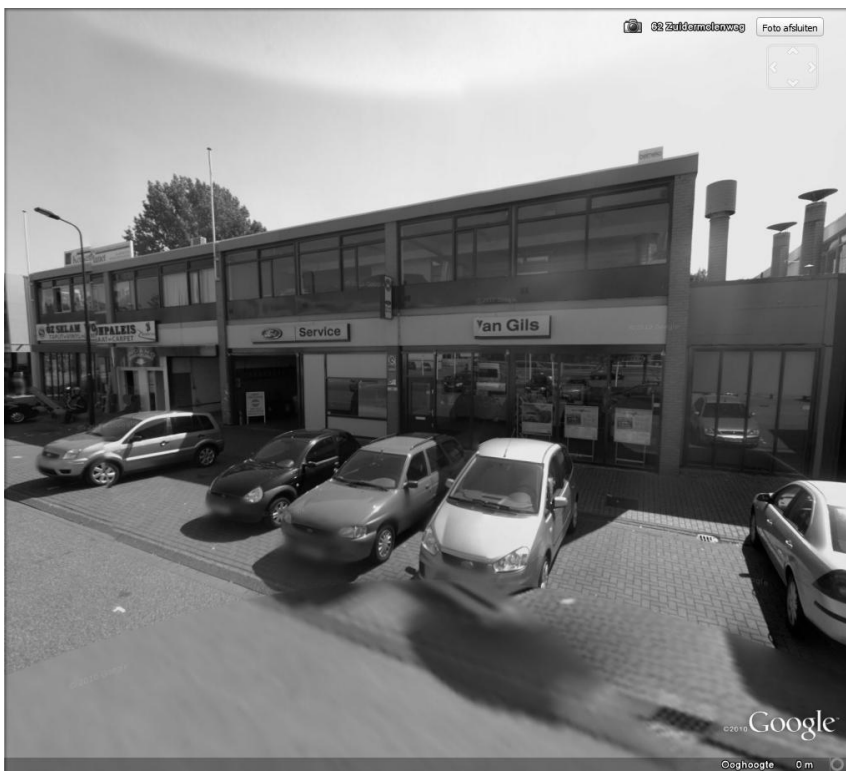
foto bestaande situatie
